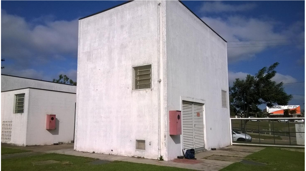
Cabine primária (A) e sala de gerador (B), futura sala de gerador / painéis
