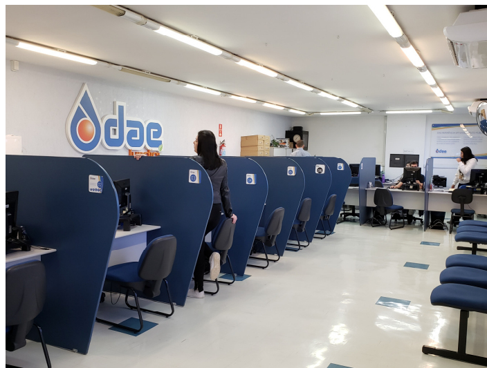
Foto 01- SALA DE ISENTOS: ao fundo, remoção de paviflex
