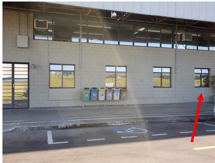
Foto 02- SALA DE ISENTOS: janela a ser removida
