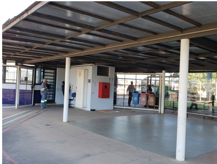
Foto 08- SALA DE INTEGRAÇÃO: demolição de piso em concreto armado.
