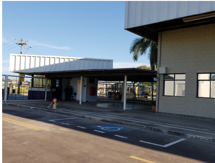
Foto 09- SALA DE INTEGRAÇÃO: fechamento em telha metálica deverá seguir o atual padrão.
