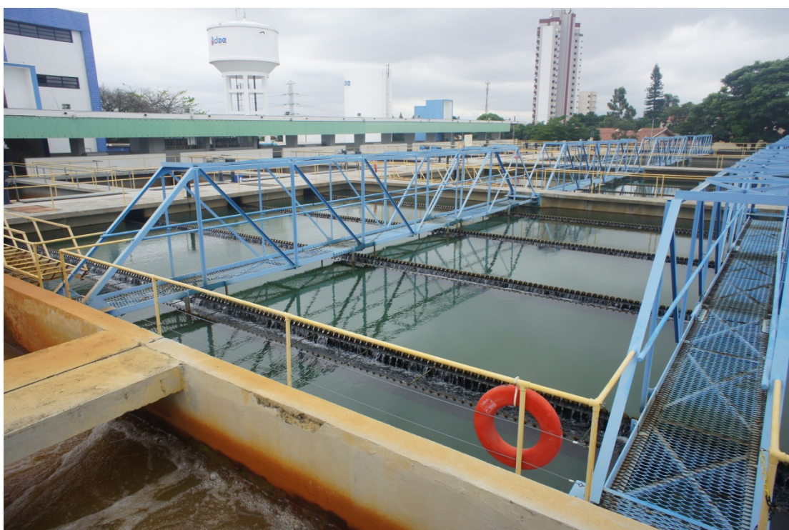
Figura 9 – Vista geral dos decantadores da ETA Anhangabaú - Decantadores convencionais de fluxo horizontal
