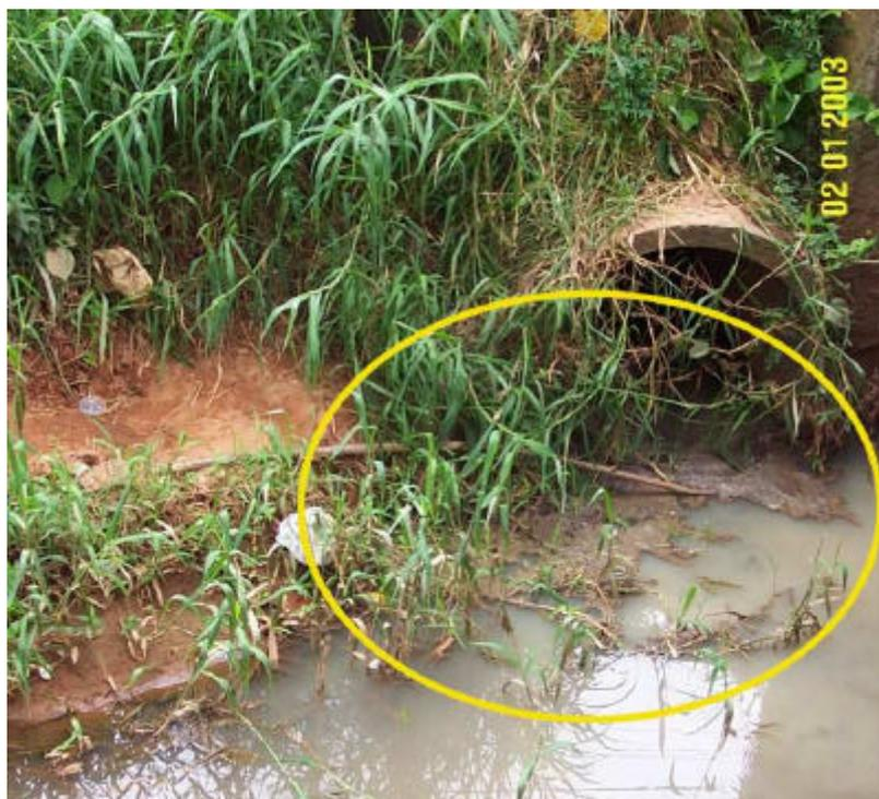
Foto 17. Lançamento de esgoto no córrego Ponte Alta (Ivoturucaia)
