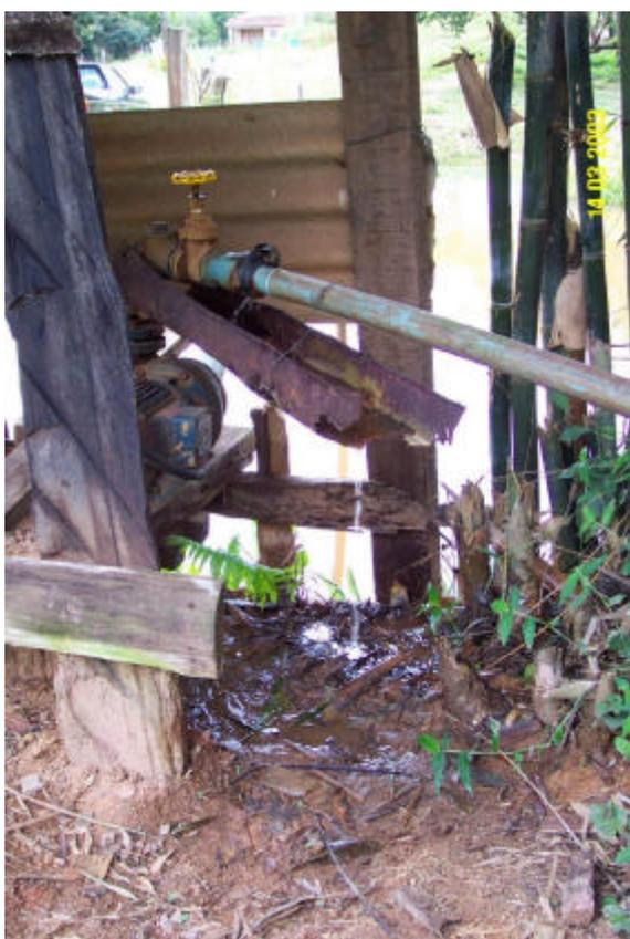
**Foto 11. Equipamento com vazamento**
