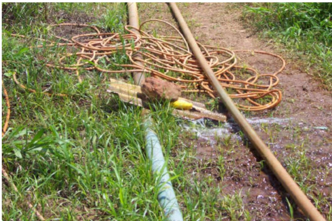
**Foto 13. Vazamento na tubulação de irrigação.**
