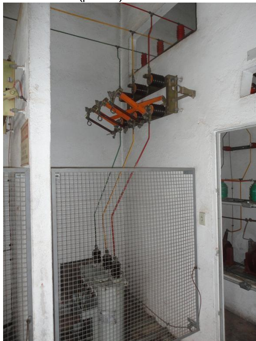
Vista interna (parcial)
