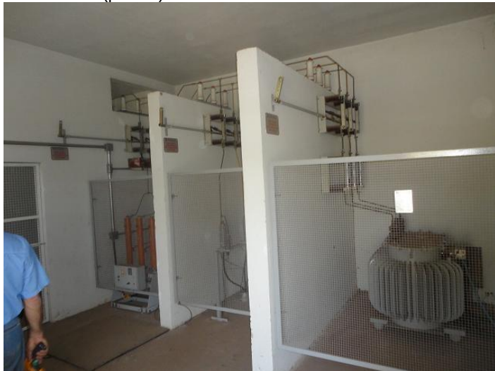
Vista interna (parcial)
