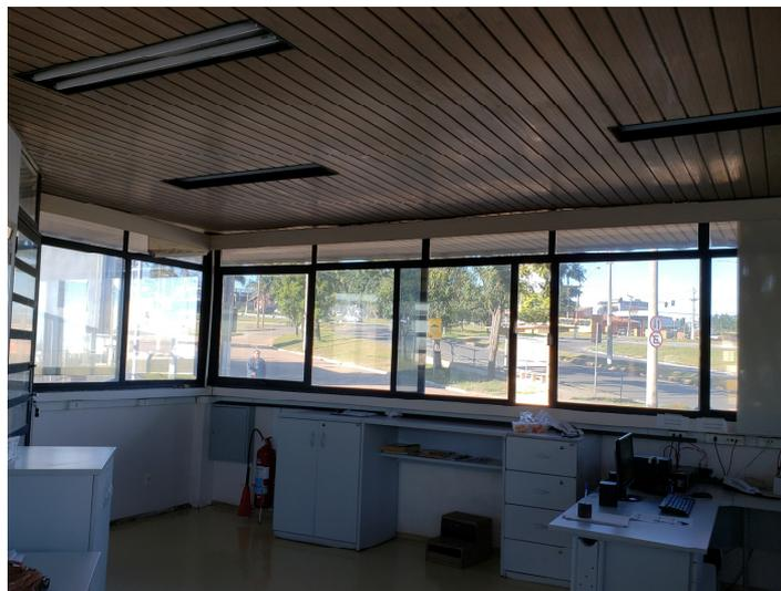
Foto 17- PORTARIA: forro PVC interno a ser substituído (dry-wall verde)
