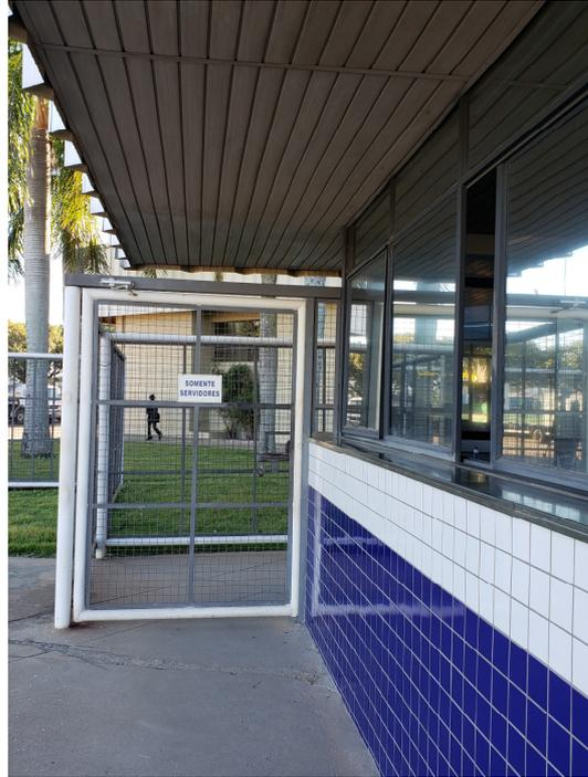
Foto 16- PORTARIA: forro PVC externo a ser substituído (dry-wall verde)
