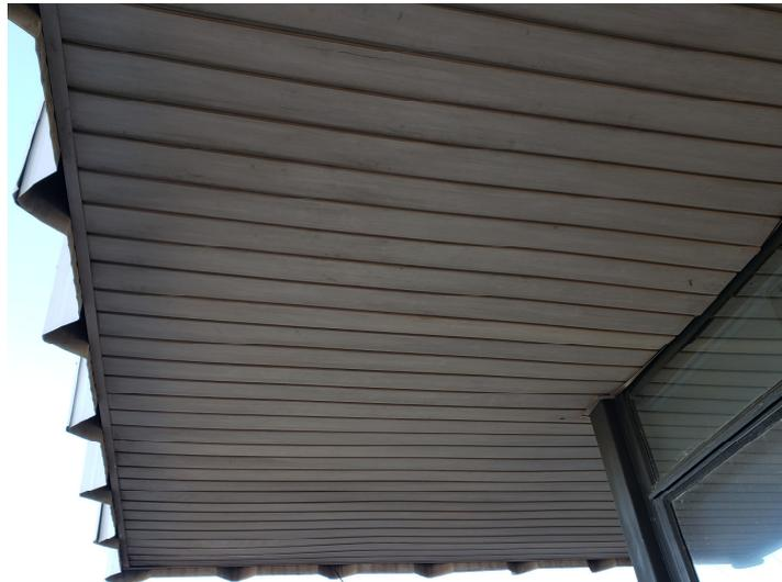
Foto 15- PORTARIA: forro PVC externo a ser substituído (dry-wall verde)
