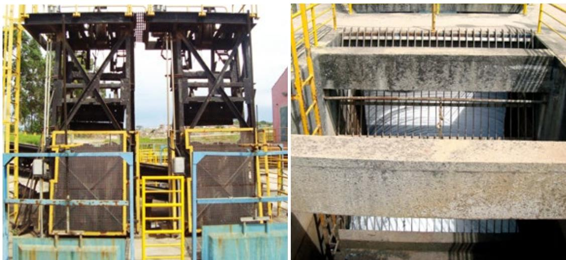
**ELEVATÓRIA:** Tem como objetivo equalizar o volume de esgoto e bombeá-lo até o tratamento, mantendo um fluxo contínuo. A instalação consiste em bombas submersas controladas através de medidores de nível e de vazão. Após o bombeamento, todo o fluxo do tratamento prossegue por gravidade.
