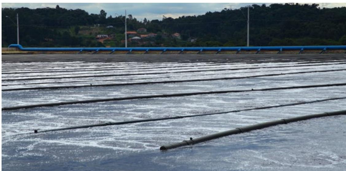
**LAGOA DE DECANTAÇÃO:** Nessas lagoas não há agitação e, com isso, os flocos de lodo formados na aeração vão ser depositados no fundo das lagoas por gravidade, formando uma camada (manto) de lodo enquanto a parte líquida, já tratada, segue para as saídas. Cada lagoa possui bombas que dragam esse lodo sedimentado através de tubulações e enviam para o local onde é feito o desaguamento do mesmo.
