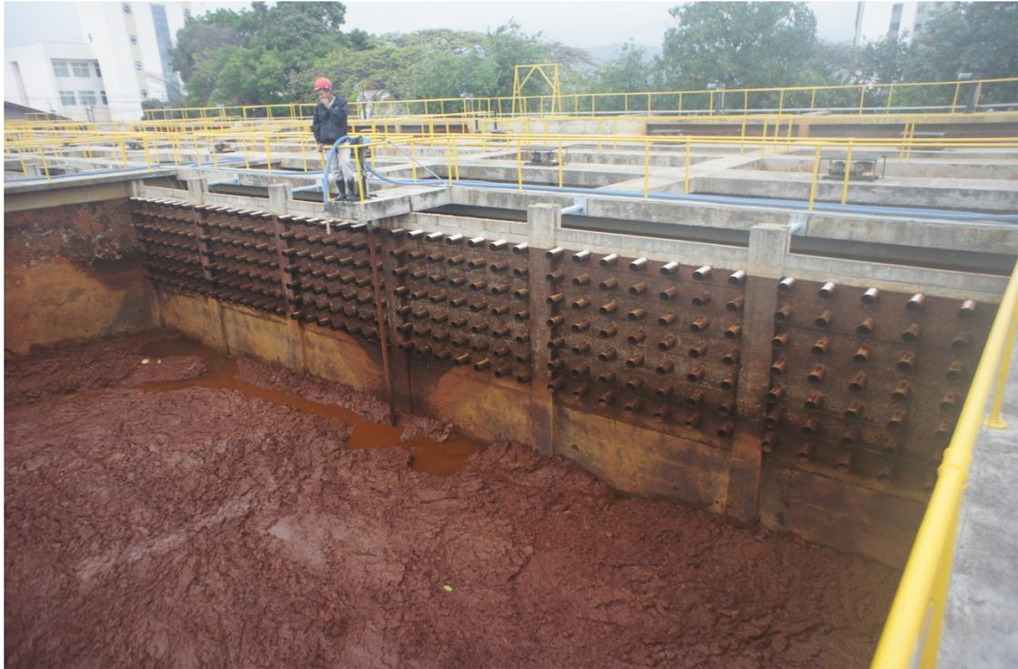
**Figura 17 – Estruturas de saída do canal de água floculada e passagem para os decantadores**
