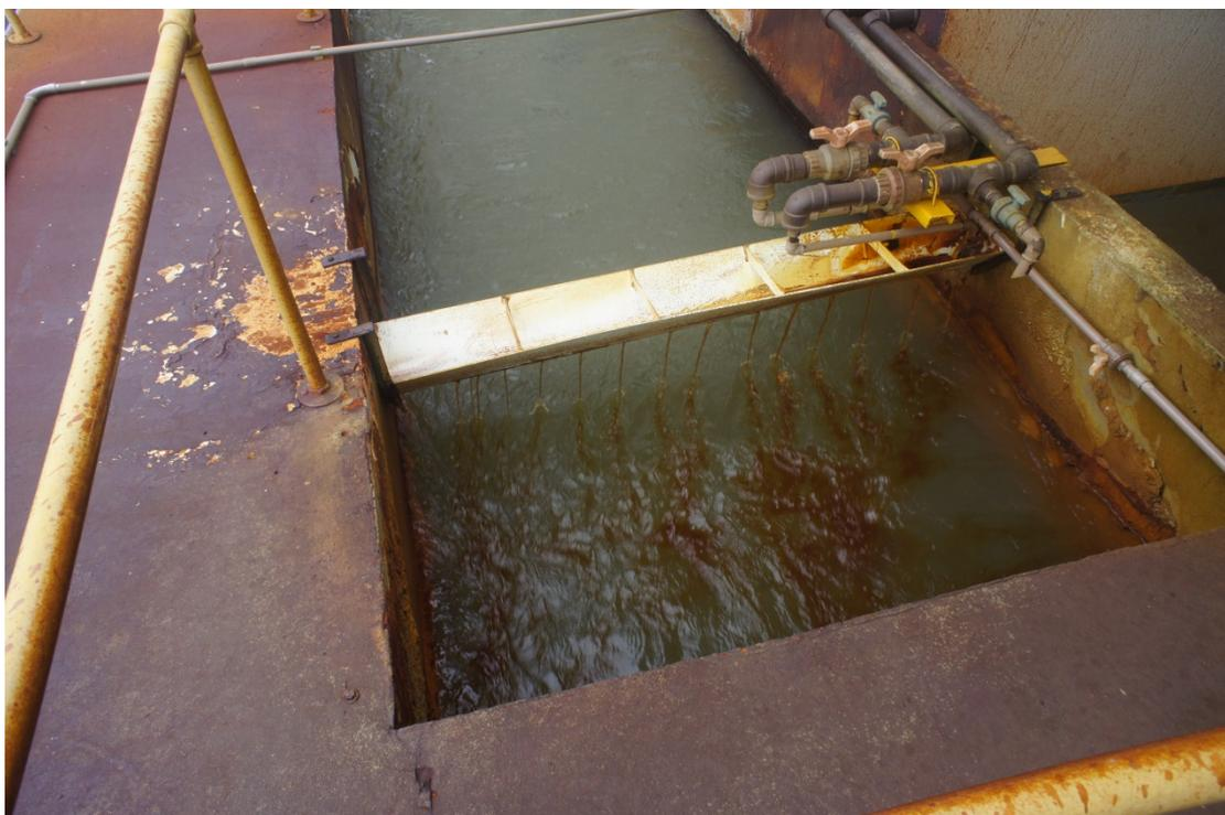
**Figura 12 – Vista geral do canal de chegada de água bruta na ETA Anhangabaú e ponto de aplicação de coagulante**
