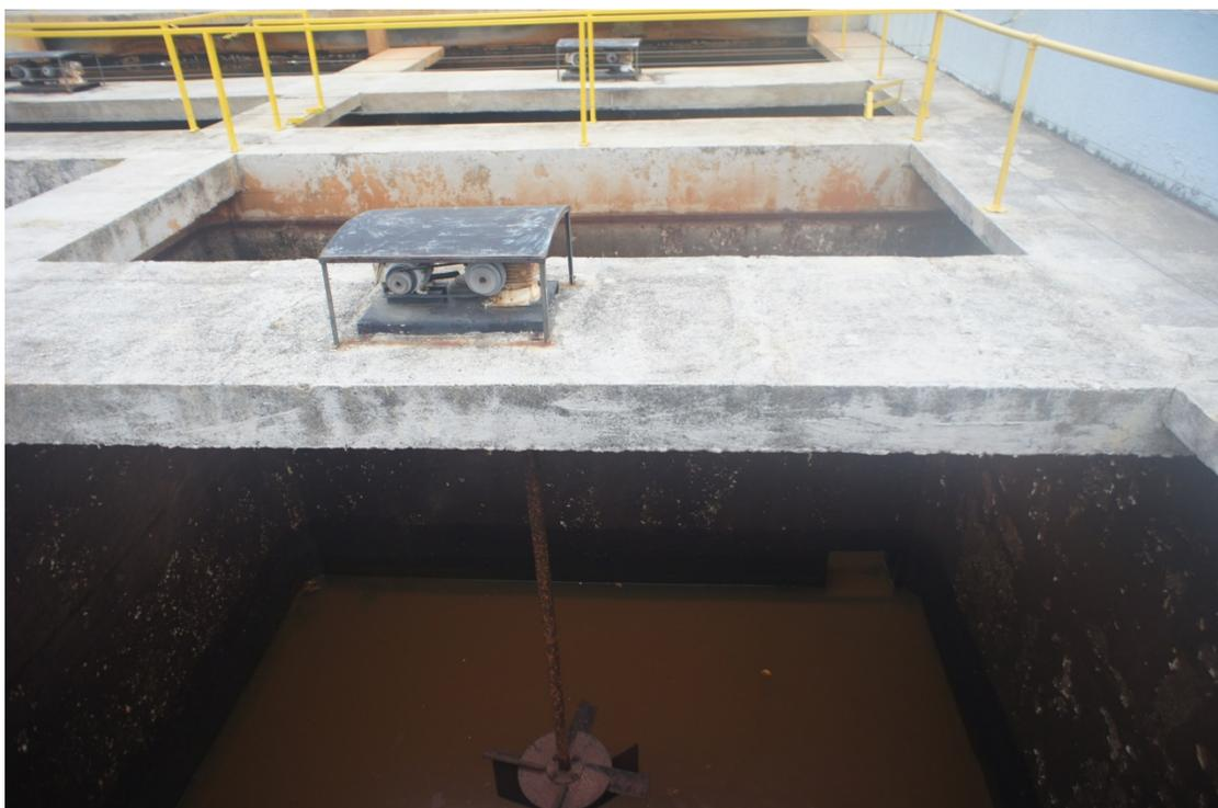
**Figura 14 – Vista das passagens inferiores entre as câmaras de floculação 1 e 2 nas unidades de floculação da ETA Anhangabaú**
