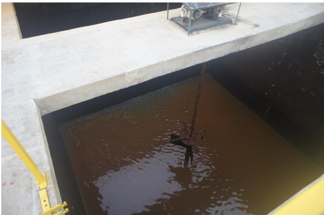
**Figura 23 – Vista geral dos equipamentos de agitação atualmente instalados nas unidades de floculação da ETA Anhangabaú**
