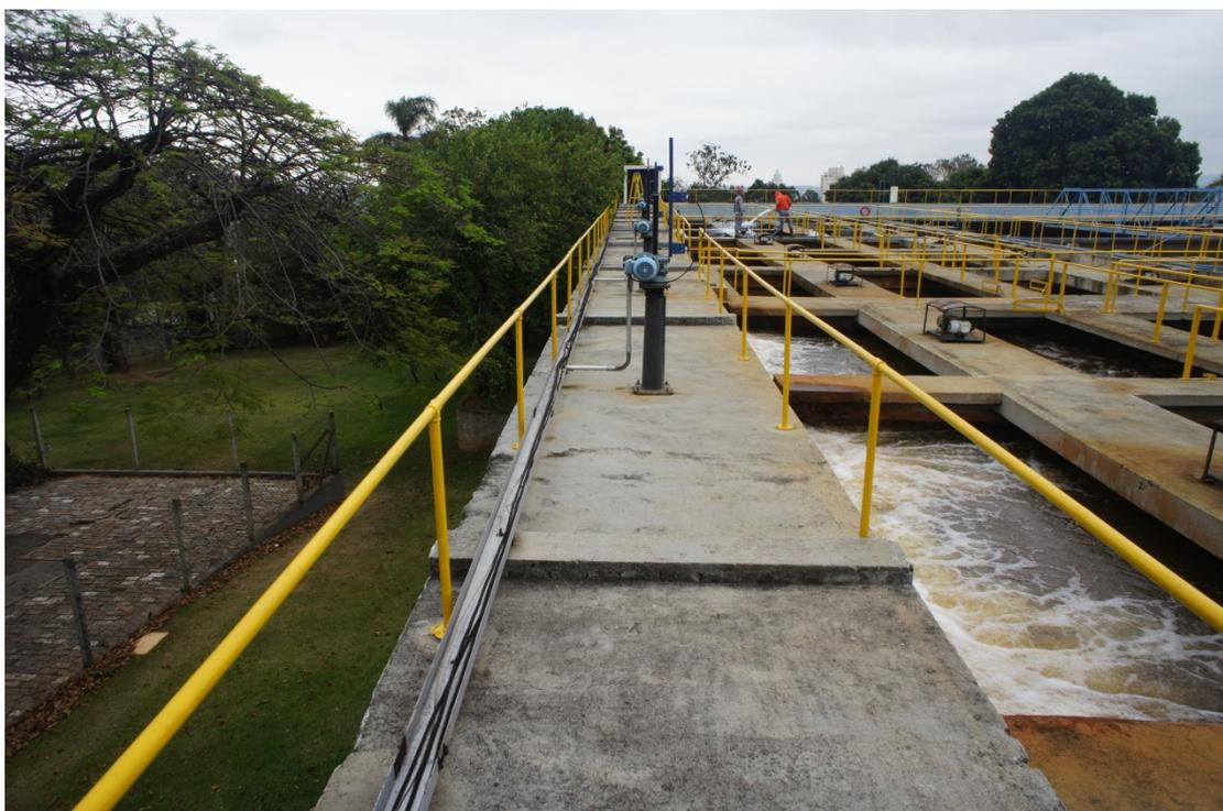
**Figura 6 – Vista geral do canal de água coagulada e sua distribuição entre as unidades de floculação e respectivos módulos de tratamento**
