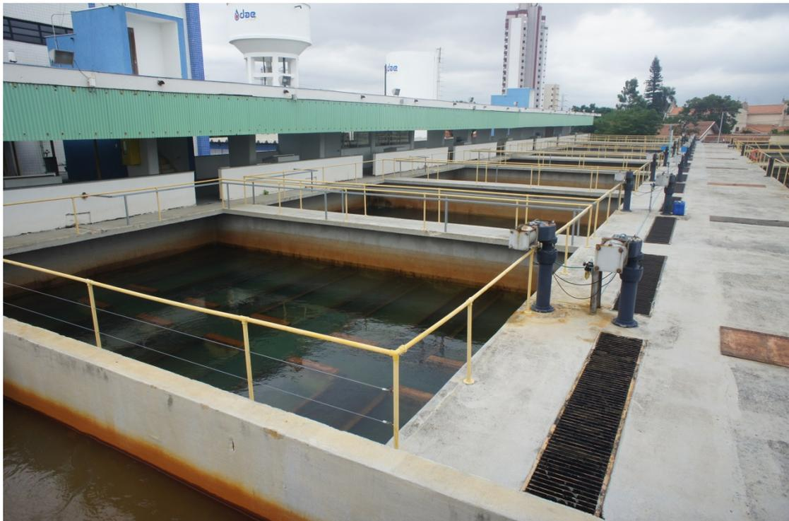
**Figura 10 – Vista geral das unidades de filtração implantadas na ETA Anhangabaú – Filtros rápidos por gravidade**
