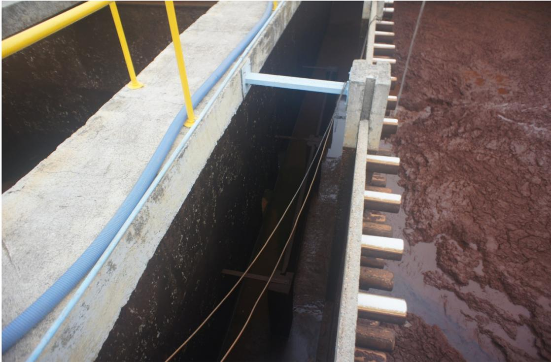
**Figura 16 – Vista das passagens inferiores entre as câmaras de floculação 3 e decantador nas unidades de floculação da ETA Anhangabaú**
