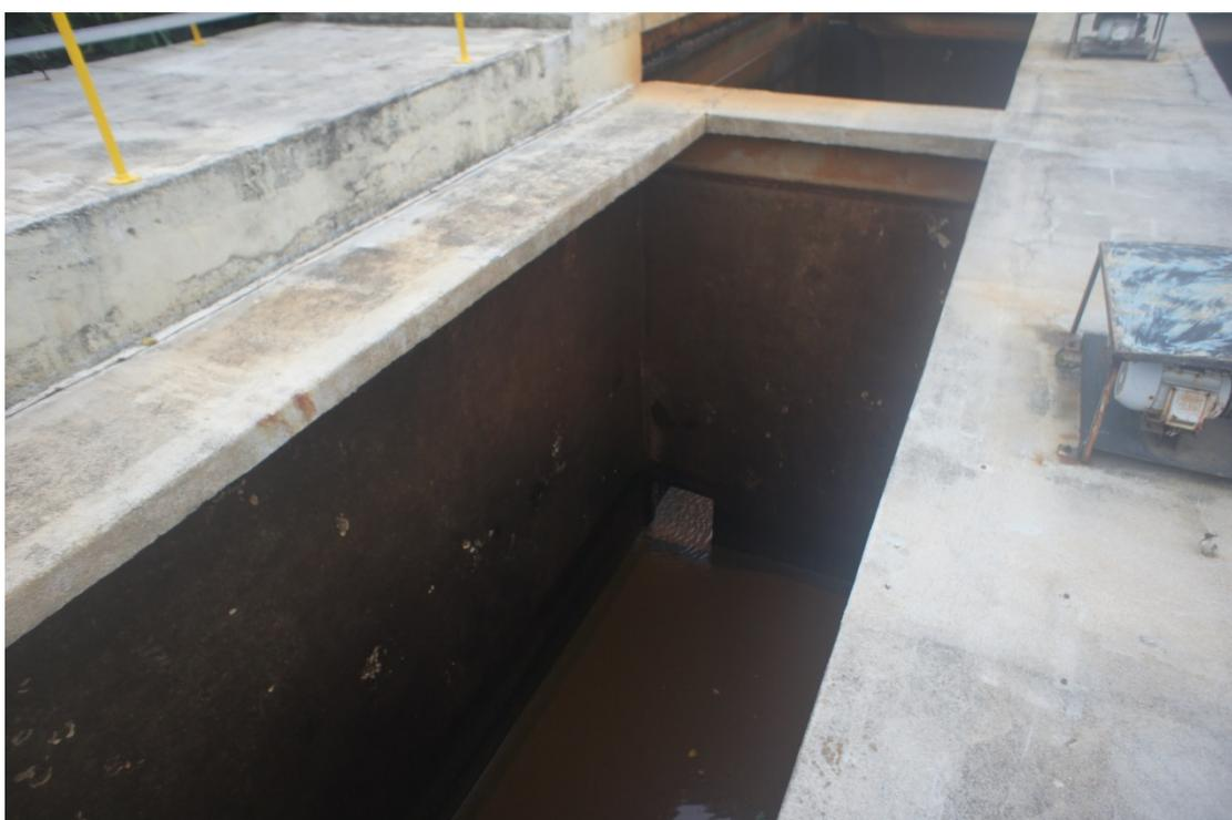
**Figura 15 – Vista das passagens inferiores entre as câmaras de floculação 2 e 3 nas unidades de floculação da ETA Anhangabaú**
