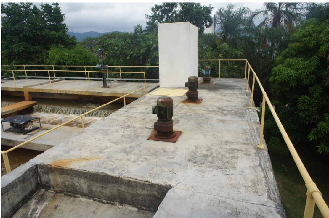
**Figura 5 – Vista geral da unidade de mistura rápida concebida para a ETA Anhangabaú – Projeto SEREC**
