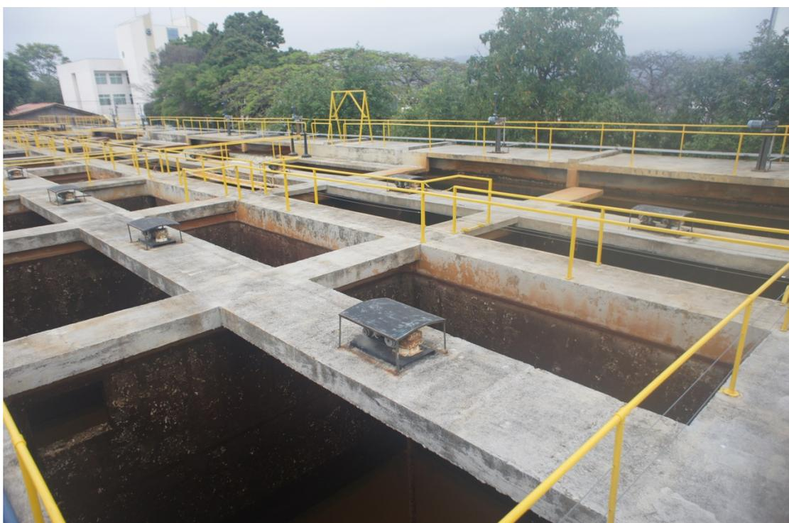
**Figura 8 – Vista geral de uma unidade de floculação típica em operação na ETA Anhangabaú**
