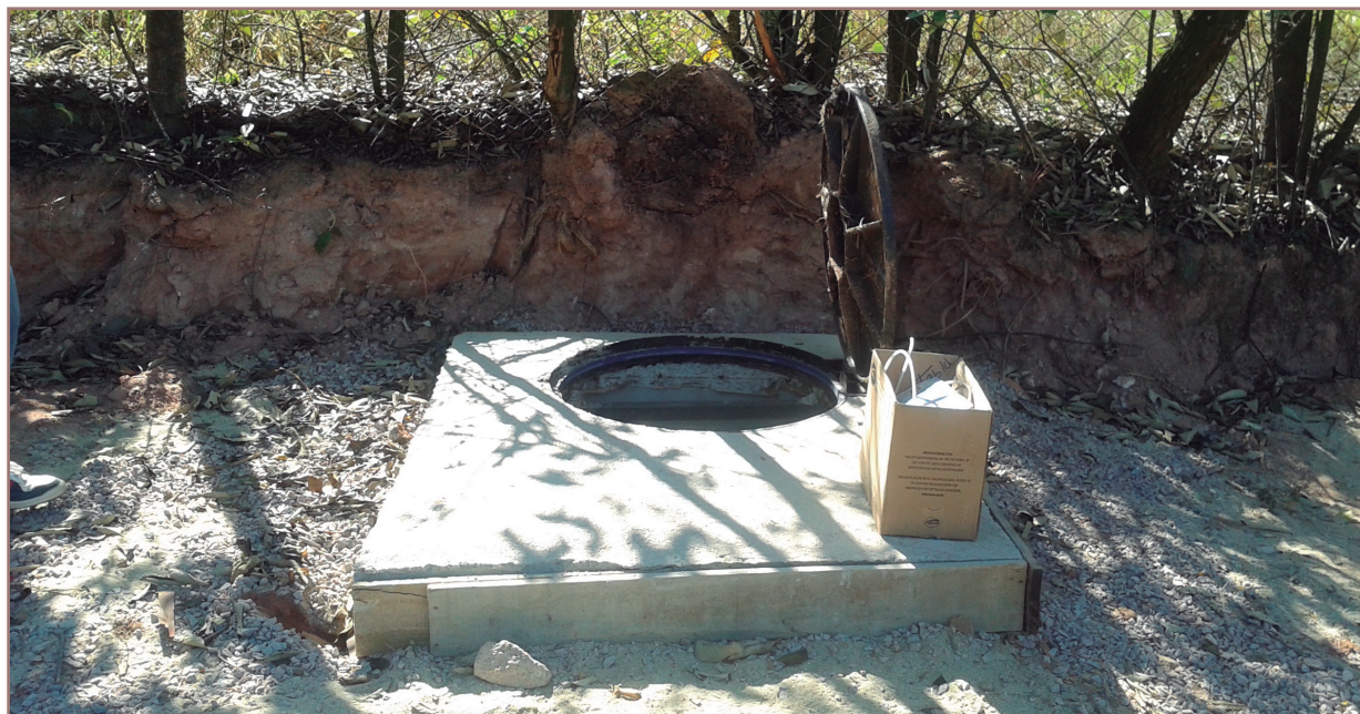
Figura 12 - Padrão do poço de visita da EP
