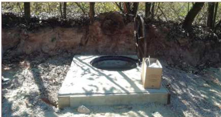
Figura 21 - Padrão do poço de visita da EP
