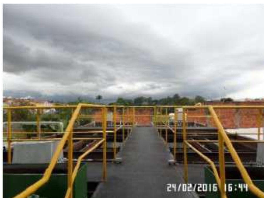
Figura 16 - Vista da ETA Eloy Chaves
