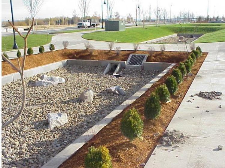
**Figura 89 – Sistema de Amortecimento e Tratamento de Águas Pluviais**
