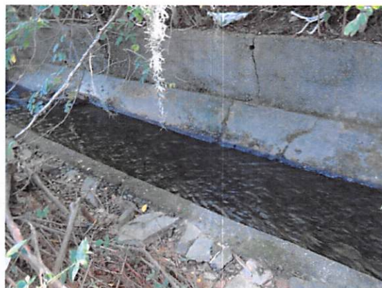
Foto 16 Área córrego canalizado SA02
