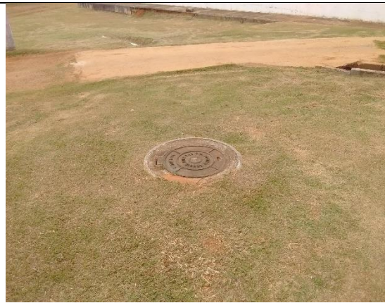
OTO 18 – LOCAL ONDE SE DEPOSITA ÁGUAS PLUVIAIS E DRENOS
