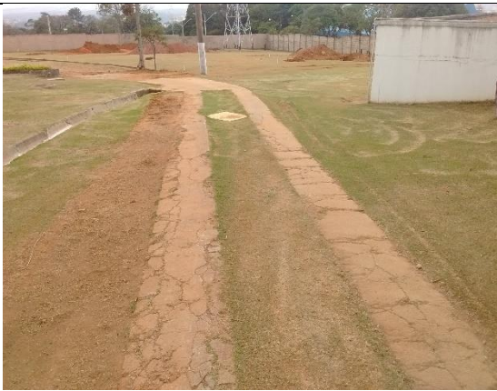
FOTO 15 – ACESSO PARA O R6
