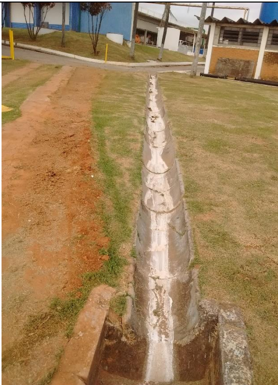
FOTO 13 – CANALETA DE DRENAGEM ASSOCIADA
