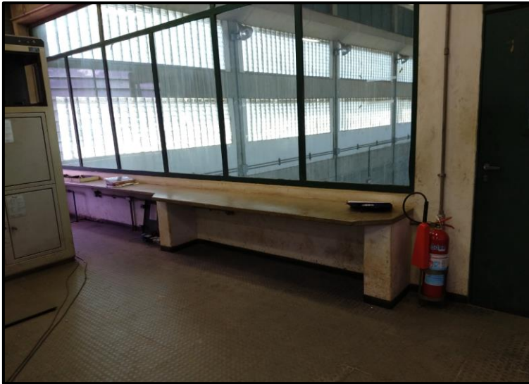
3.4.5 Foto - Bancada de alvenaria a ser removida.
