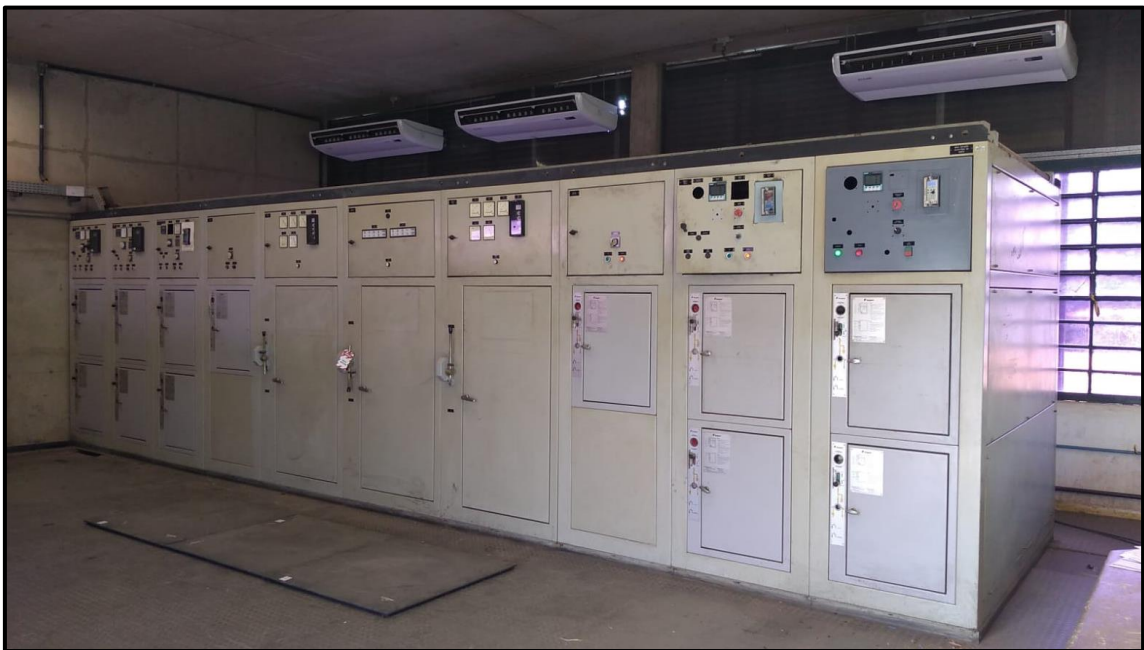
3.4.4 Foto - Painele de acionamento das bombas a ser removido.
