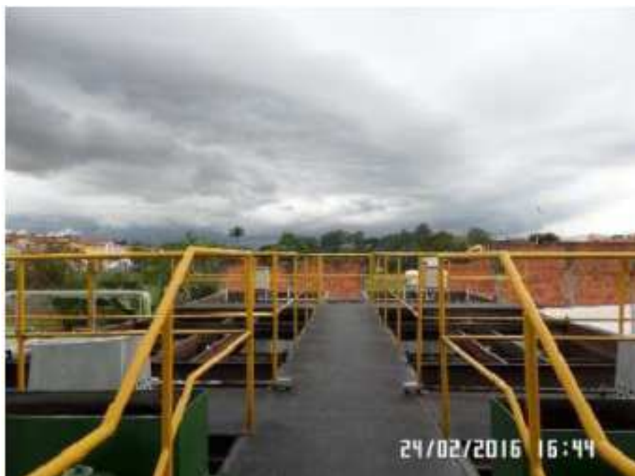
Figura 16 - Vista da ETA Eloy Chaves
