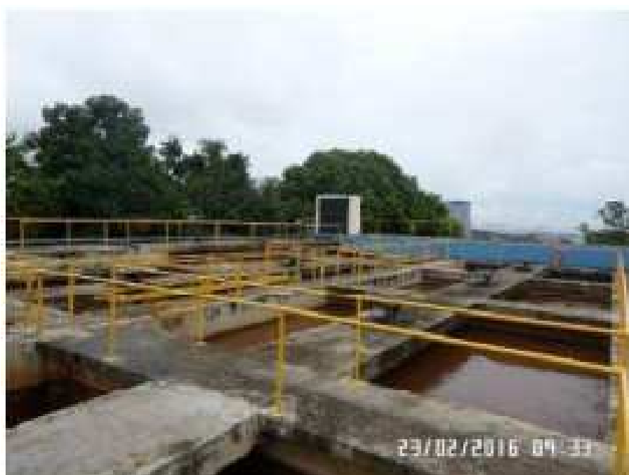
Figura 14 - Vista da ETA Anhangabaú, gerenciada pela DAE S/A
