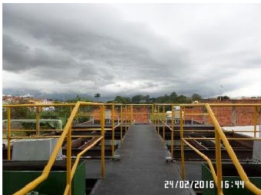
Figura 16 - Vista da ETA Eloy Chaves
