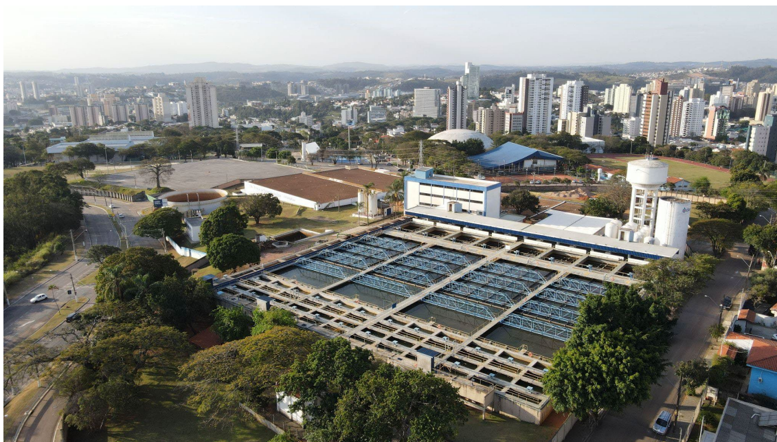
Figura 14 - Vista da ETA Anhangabaú, gerenciada pela DAE S/A
