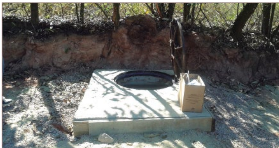
Figura 21 - Padrão do poço de visita da EP
