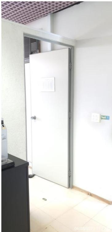
Foto 11– Parede de drywall da sala de reuniões
