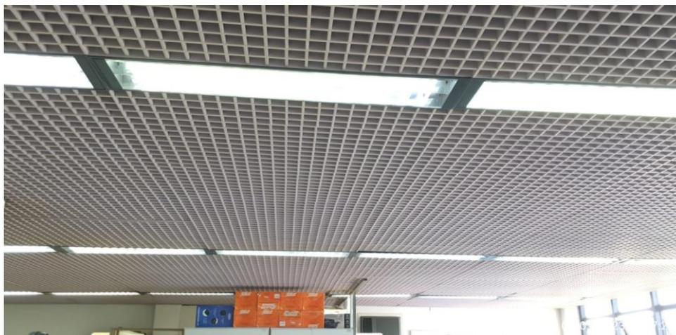
Foto 15 – Luminárias no forro metálico
