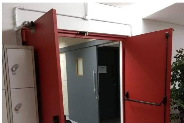
Figura 83– ILUSTRAÇÃO DE FECHADURA ELETROMAGNÉTICA INSTALADA
