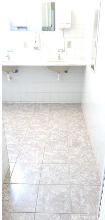
Foto 05 e 06 – Piso e Revestimento cerâmico dos sanitários, a serem removidos
