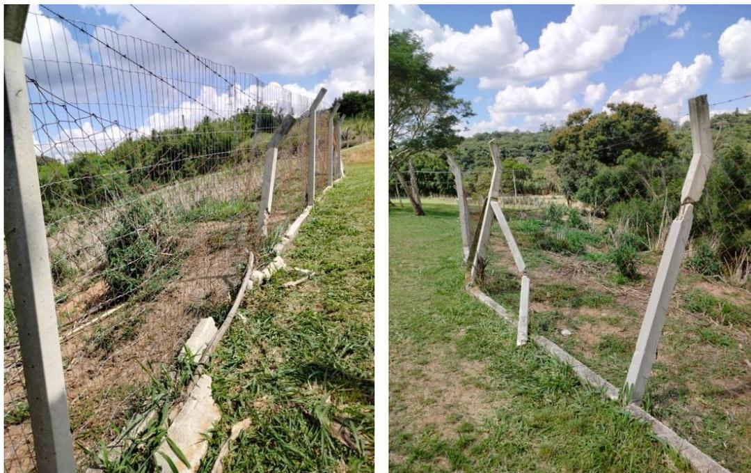
**Figura 6 e 7 - Mourões quebrados e telas danificadas**
