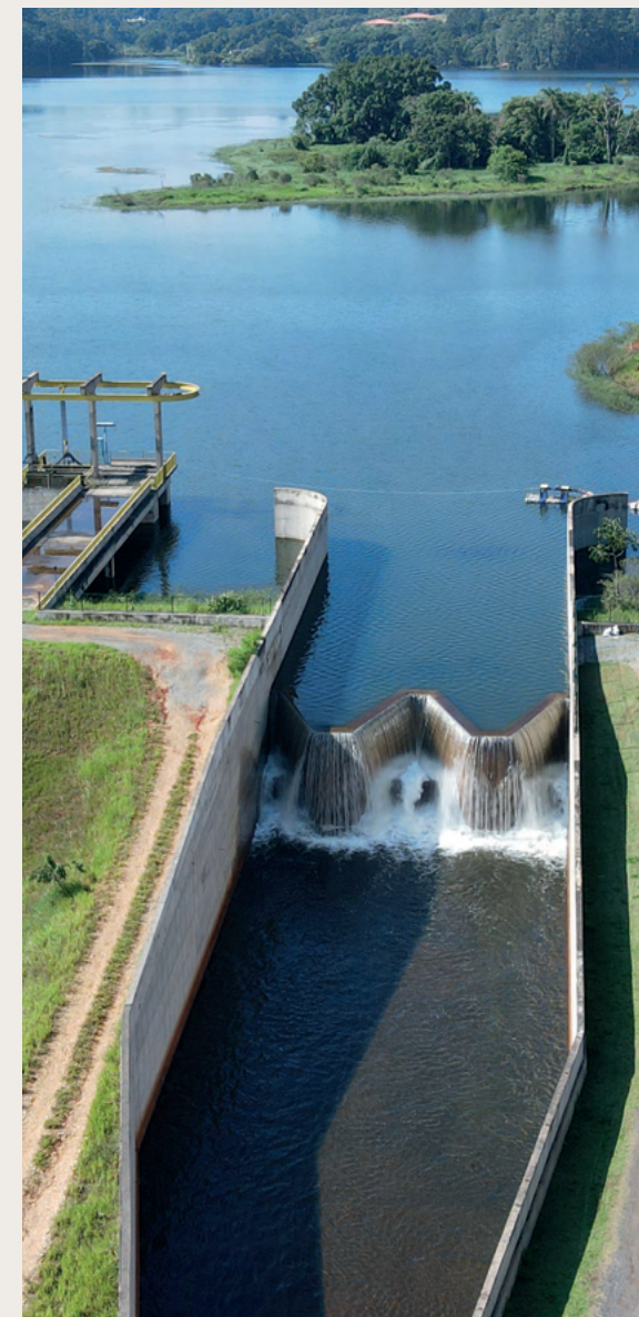
Vertedouro na Represa de Acumulação
