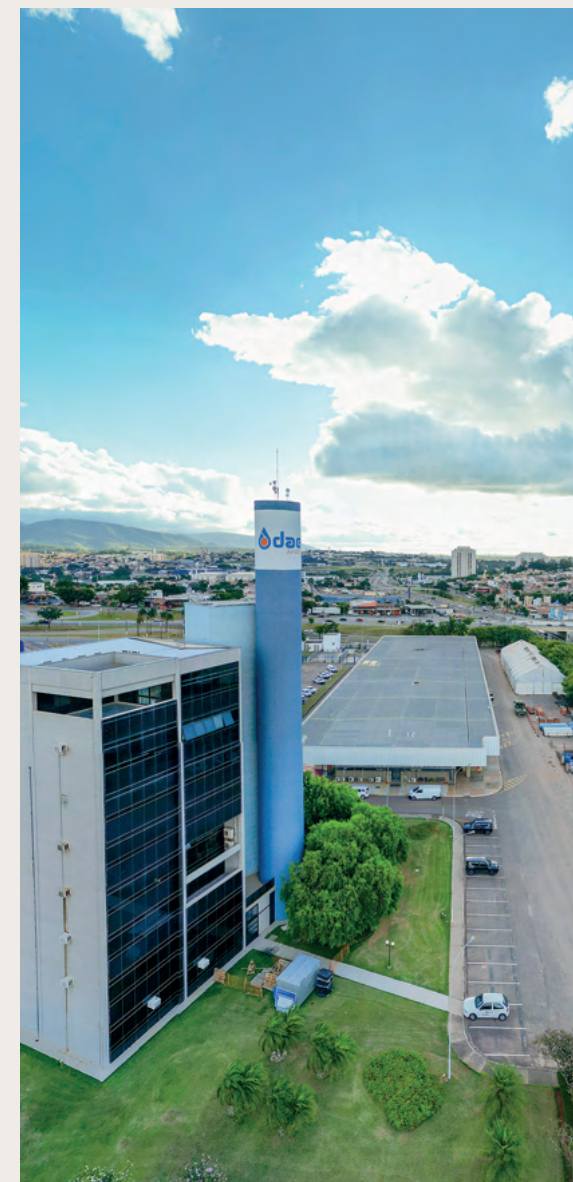
Sede Administrativa e Operacional
