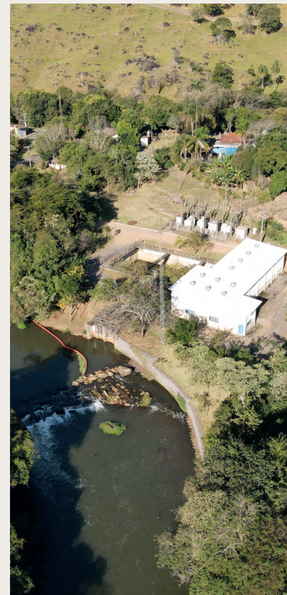
Casa de bombas, rio Atibaia
