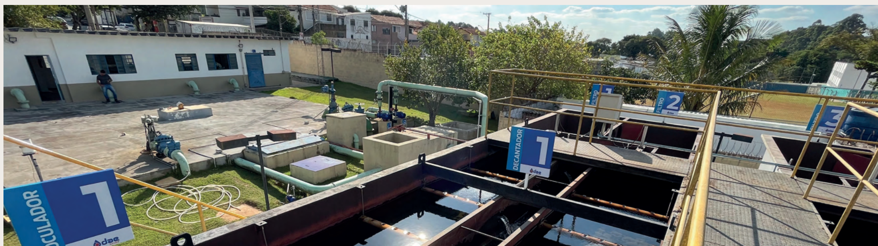
Estação de Tratamento de Água do Eloy Chaves
