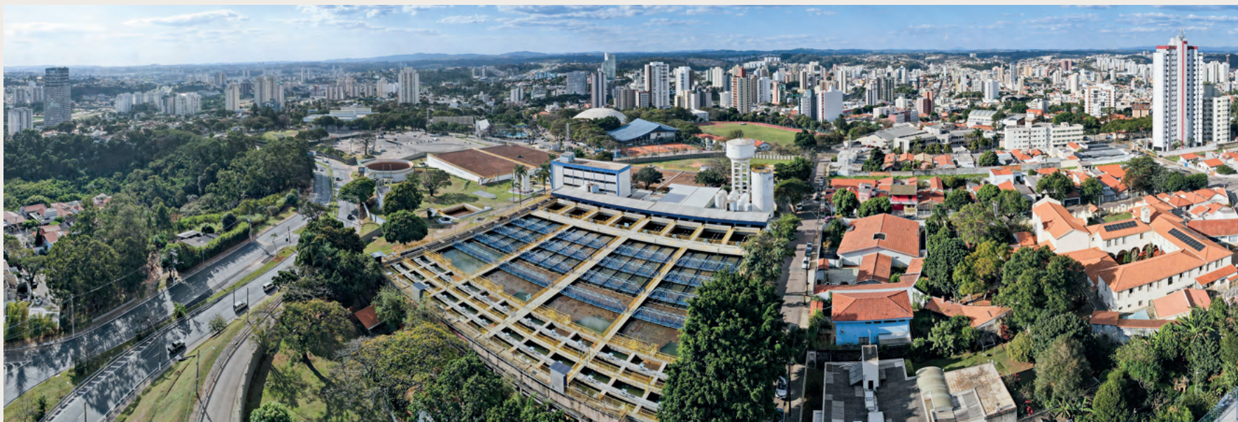
Estação de Tratamento de Água do Anhangabaú - ETA-A
