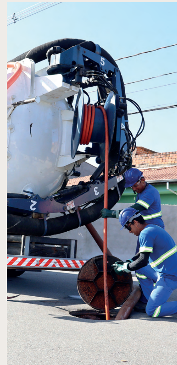
Serviço de hidrojateamento, rede de esgoto
