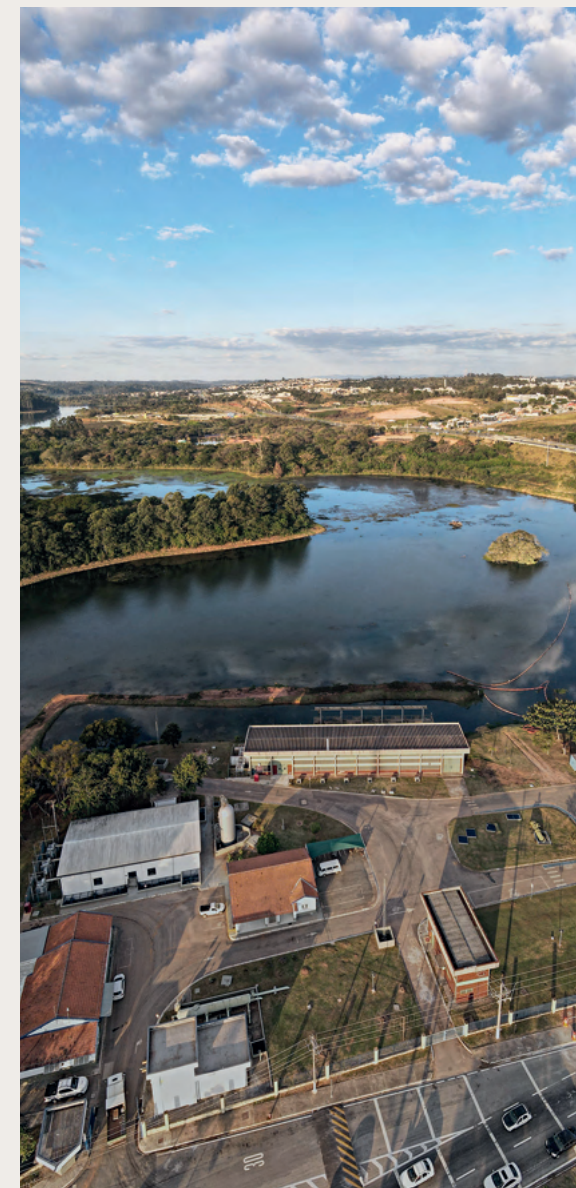
Estação Elevatório de Água Bruta
